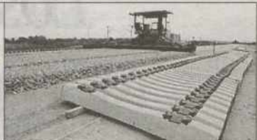
Estado de las obras del AVE la pasada semana.
