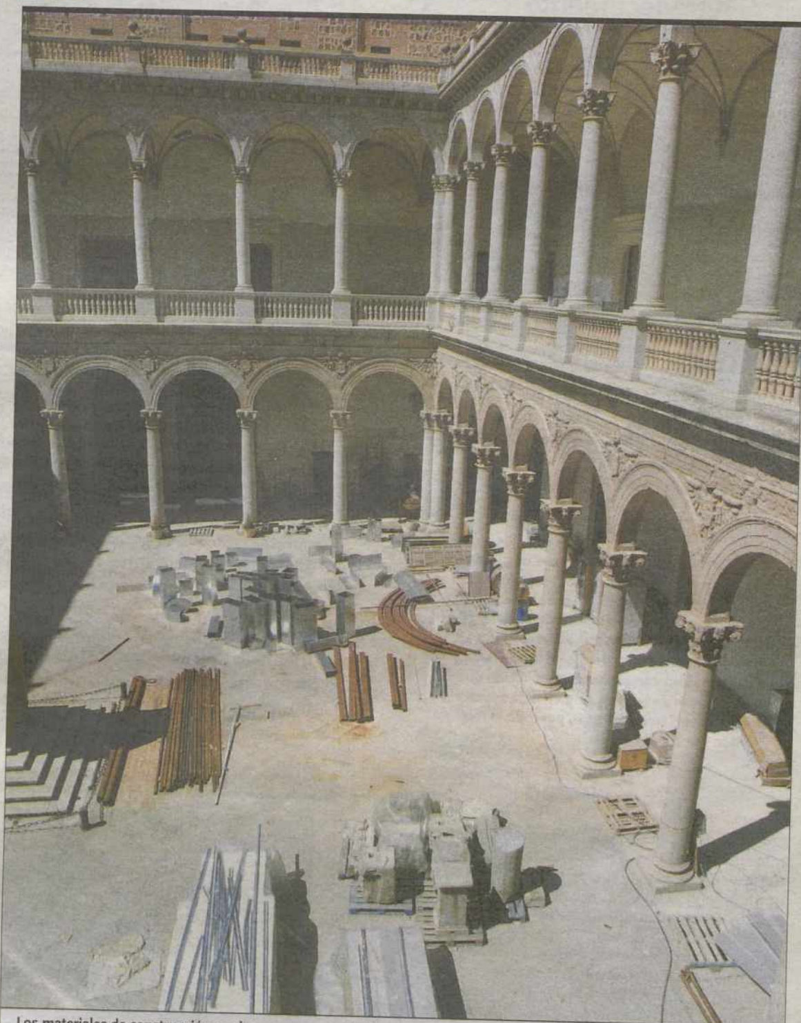
Los materiales de construcción se almacenan por todo el patio del Alcázar. / VÍCTOR BALLESTEROS
