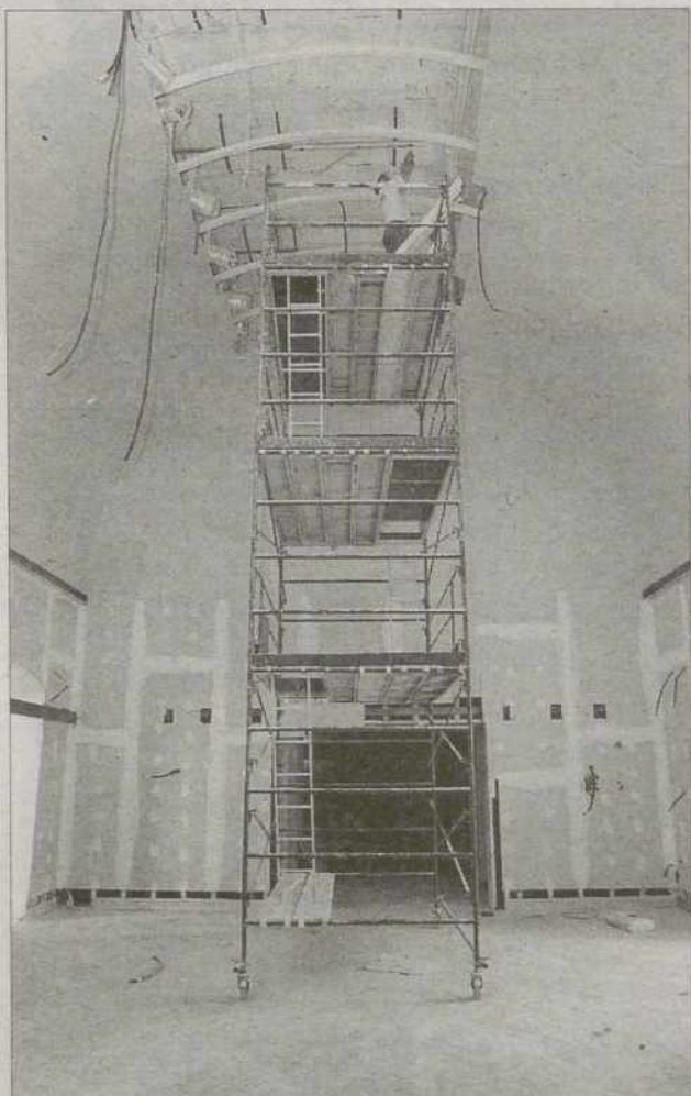
A la espera de rematar. Algunas salas de exposición se encuentran a la espera de los remates finales. El grueso de la obra está llegando a su fin. / FOTO: V.B.
