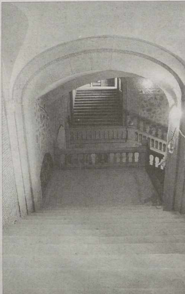
Aspecto final. Son numerosas las partes del Alcázar Imperial que, pese a la suciedad de cualquier zona en obras, se hallan rehabilitadas por completo. / FOTO: V.B.
