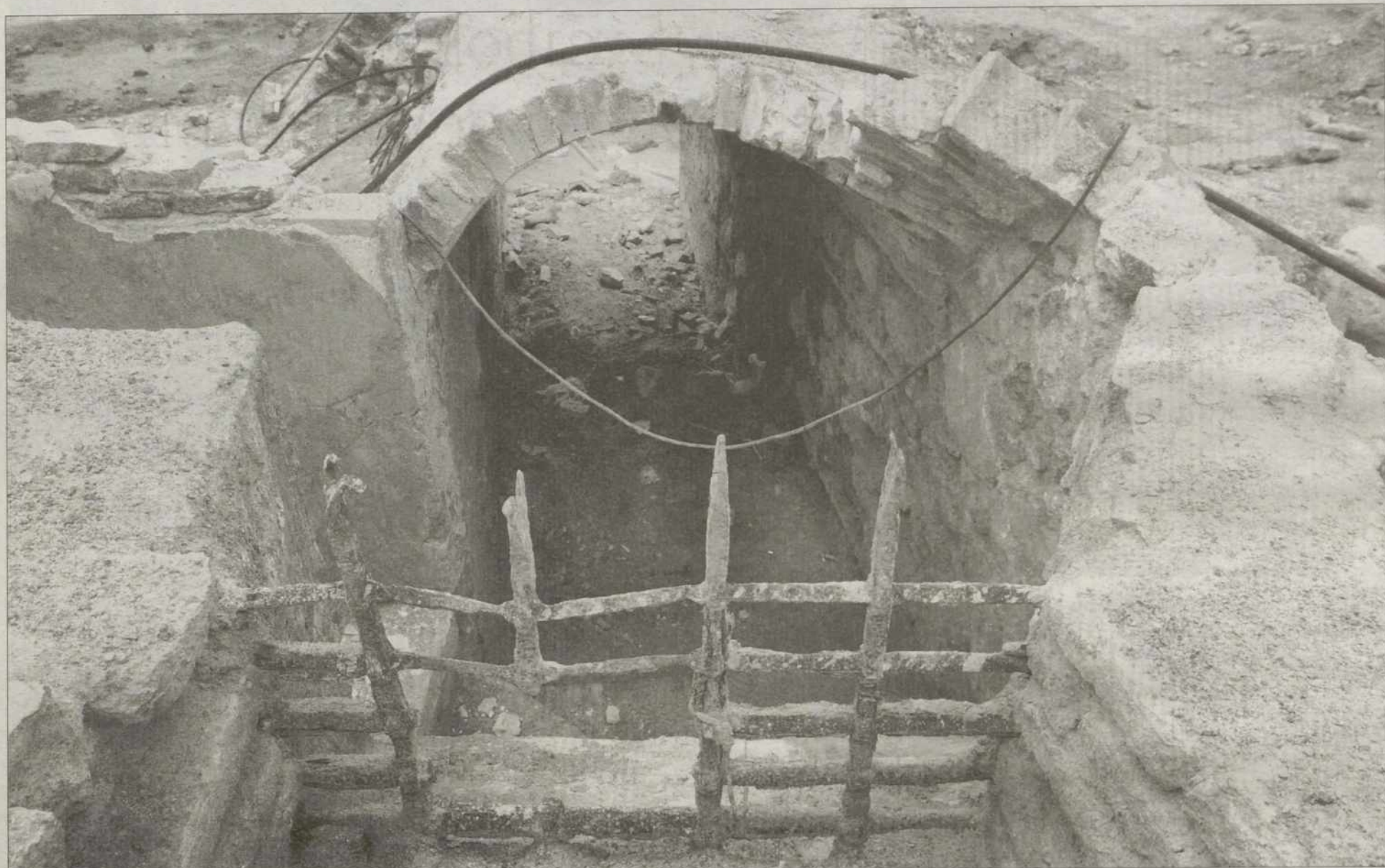
Bóveda de ladrillo: el mejor sistema para repartir los empujes de las edificaciones superiores. / YOLANDA LANCHÁ
