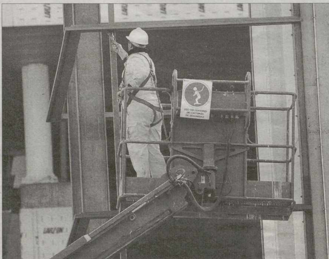
Un operario trabajaba ayer en las obras del Pabellón Ferial donde hace más de una semana falleció un trabajador. / R. VIADERO
