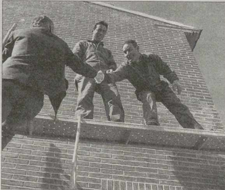
Camacho sube al andamio de una obra para saludar ayer a unos obreros. / R. V.
