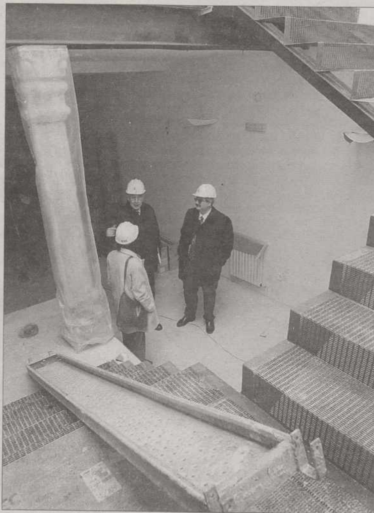
El arquitecto (c.) explica las obras a la vicerrectora y al consejero. VALDIVIELSO
