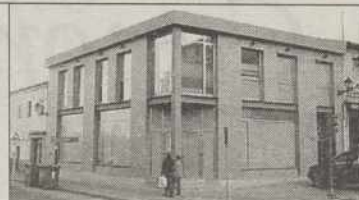
Edificio donde se ubicará por el momento el Juzgado de Guardia.
