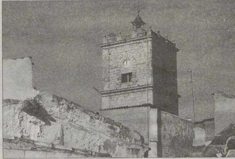
En restauración. La Iglesia de El Toboso se encuentra en plena fase de restauración de su techumbre. Sin duda es uno de los lugares que no hay que perderse en la visita al municipio.
