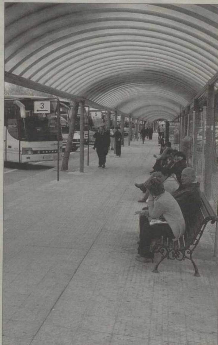
La falta de luz en la futura estación es la principal queja./MANU REINO
