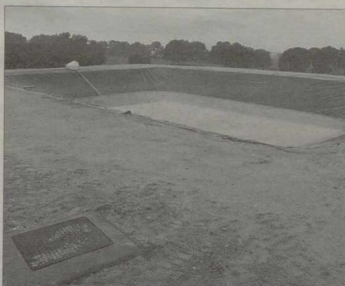
La balsa recibe por alcantarillado las aguas residuales. / R. VIADERO
