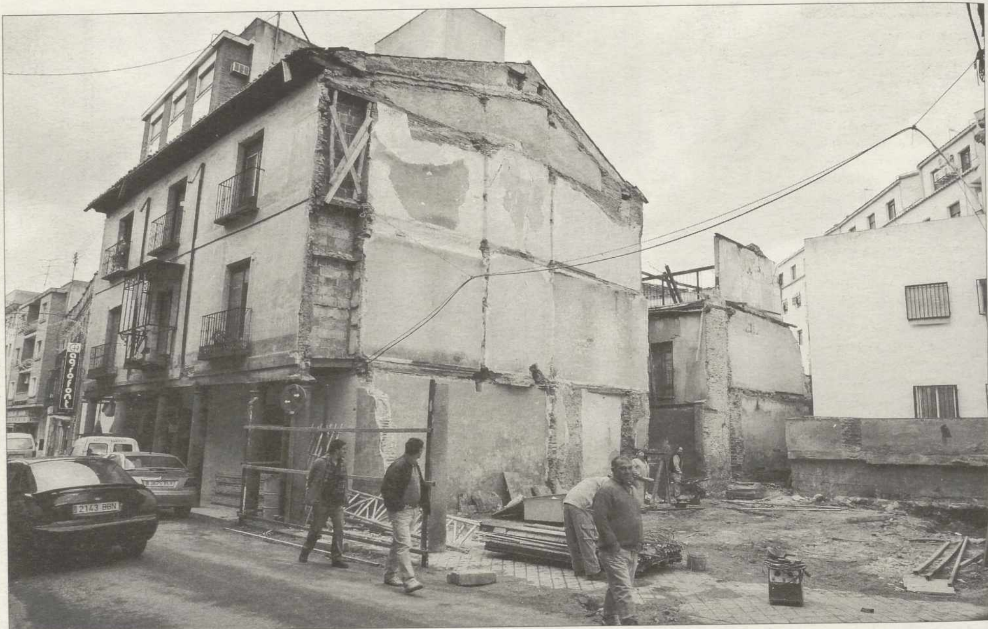
Este es el solar en el que se encontraba el edificio demolido, por lo que ahora tan sólo queda un inmueble con soportales en la Corredera del Cristo/R. VIADERO
