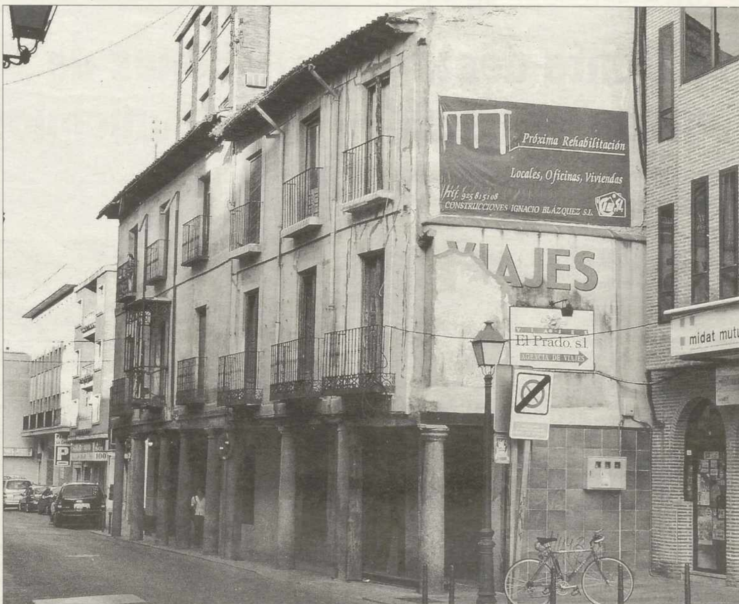
Éste era el aspecto que presentaba la Corredera del Cristo antes de que el edificio fuera derribado/R. VIADERO
