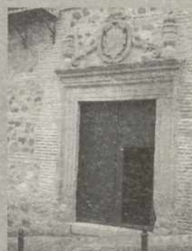
84 EDIFICIOS EN REHABILITACIÓN
