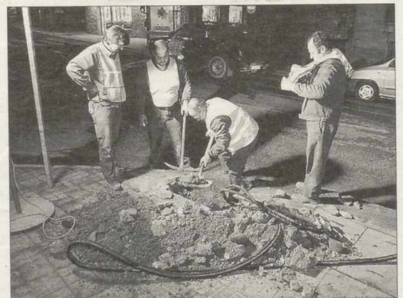
Operarios de Aguas Toledo, intentando localizar la tubería. / DAVID PÉREZ
