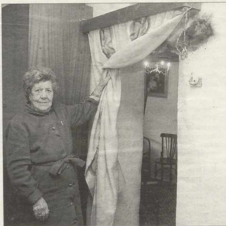
Carmen muestra parte de la gotera que ha aparecido en su casa. / Y. LANCHÁ
