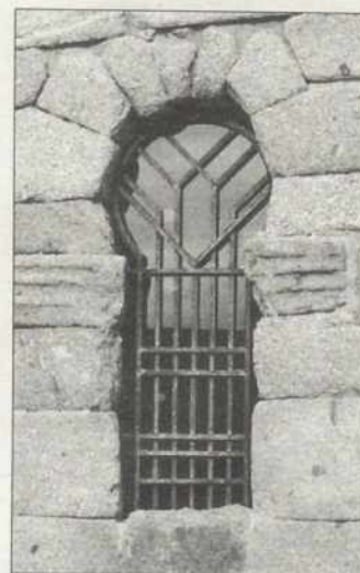
Un detalle del nuevo enrejado
