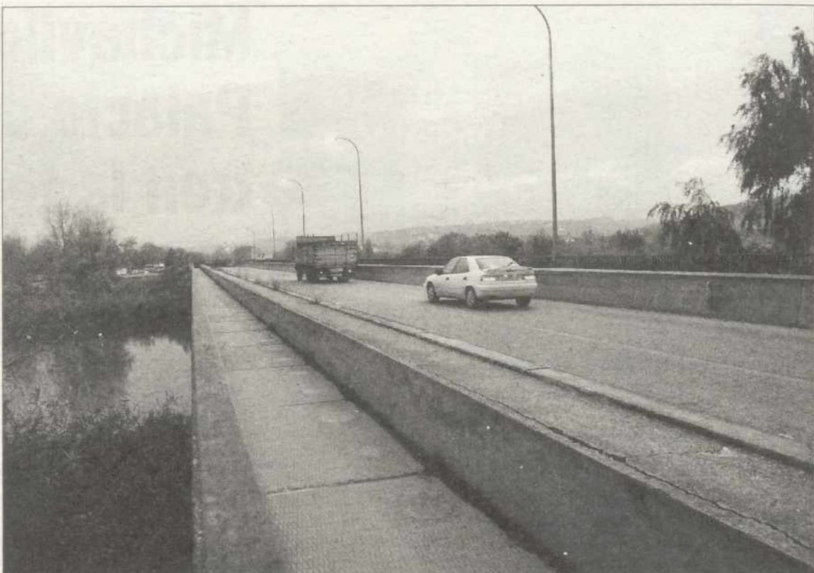
El puente es uno de los más transitados de la ciudad por camiones pesados. / DAVID PÉREZ
