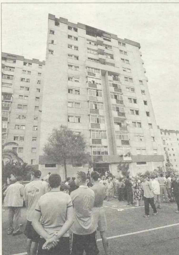
Varios vecinos esperan a que los bomberos inspeccionen el edificio siniestrado. /EFE
