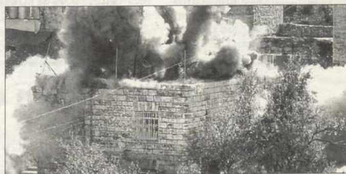
Aspecto que presentaba la vivienda demolida ayer. / AP
