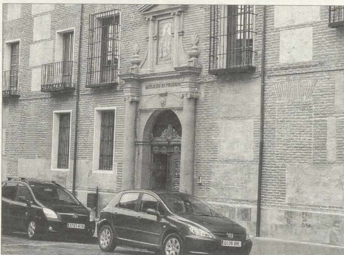
Las obras de San Prudencio se encuentran ya completamente finalizadas./VIADERO
