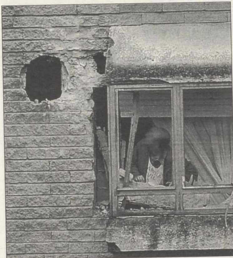
Aspecto de la fachada del cuartel de Urdax
