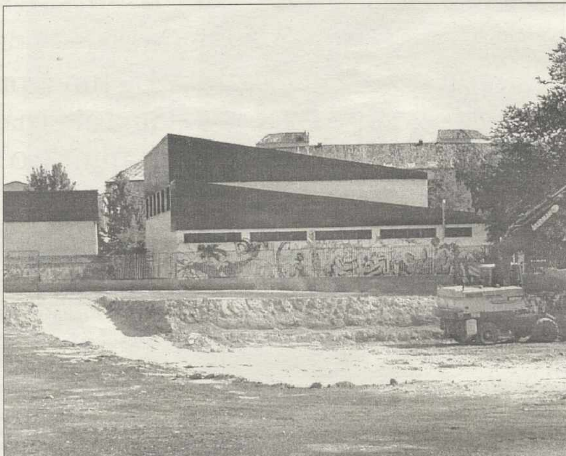
Este es el aspecto que presentan las obras en la Avenida Camilo José Cela
