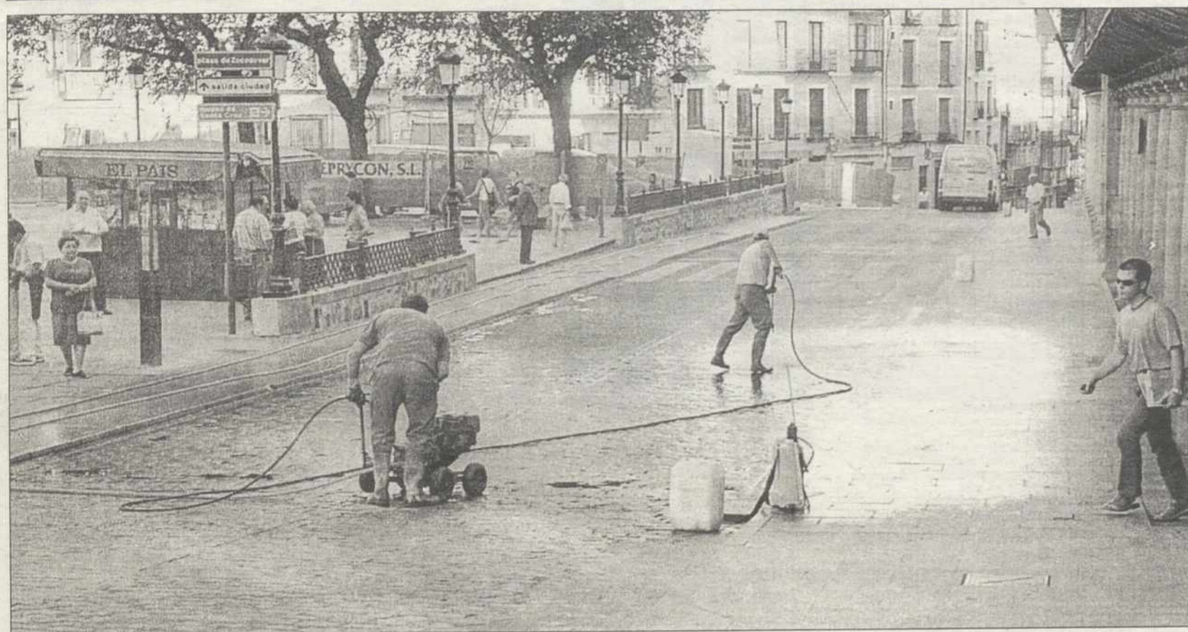
Desde ayer varios operarios trabajan en la conservación y mantenimiento del hormigón impreso de la calzada
