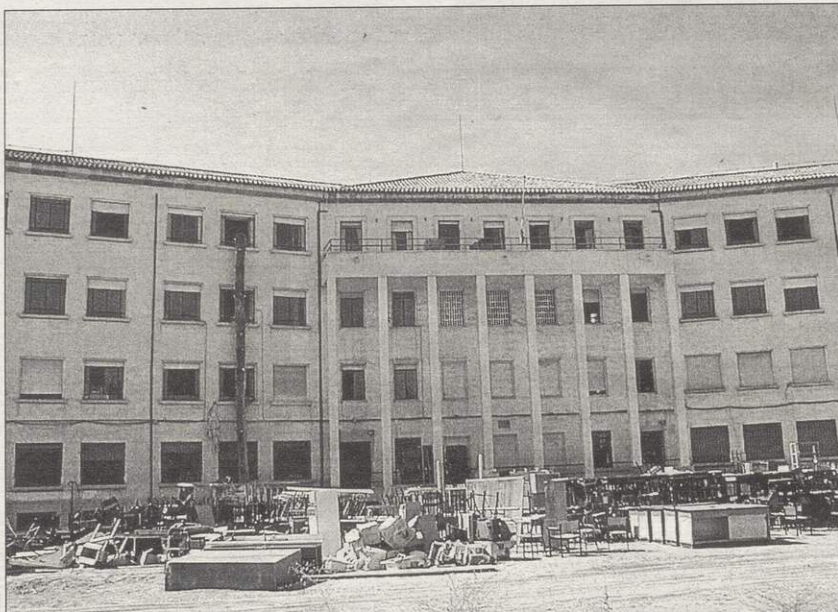
Ya han comenzado las obras en el futuro IES de la Escuela de Magisterio de Toledo
