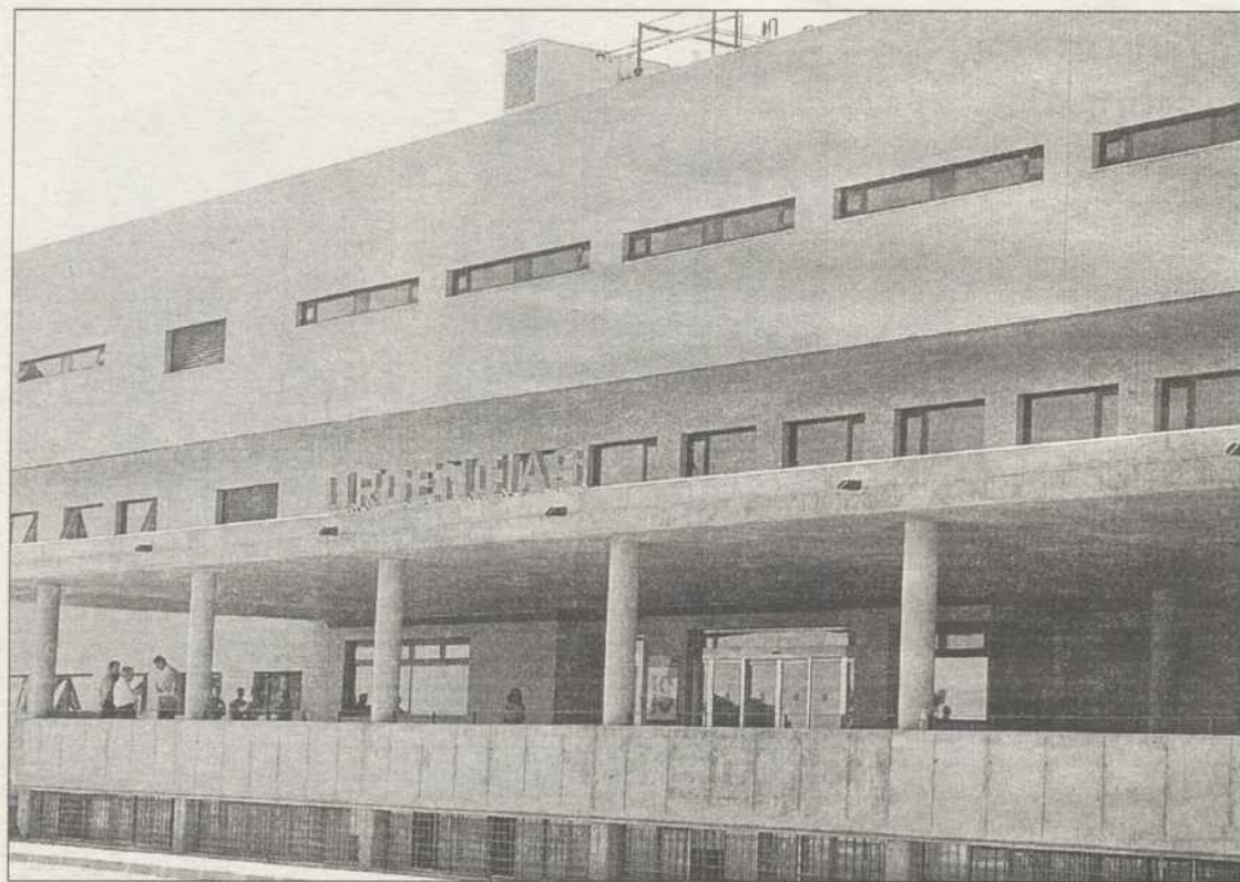
SATSE denuncia las deficiencias con las que han comenzado a funcionar las nuevas Urgencias
