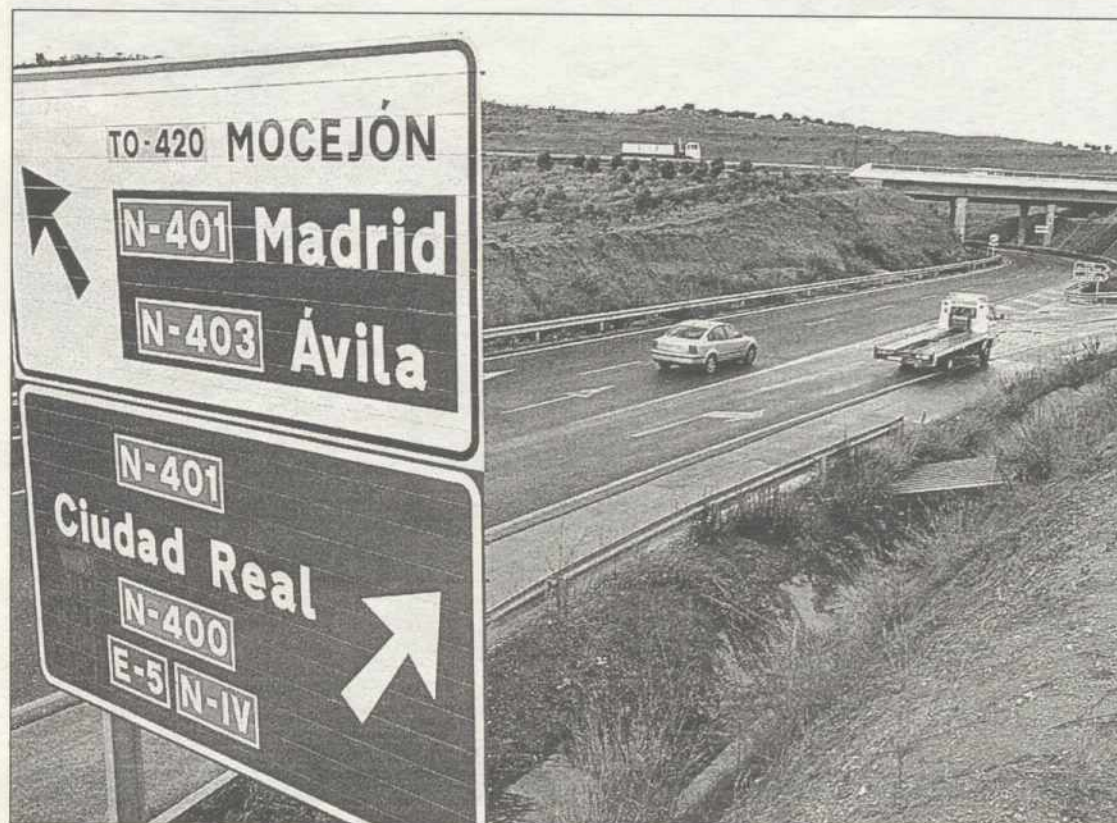
Fomento licitó las obras el pasado mes de enero
