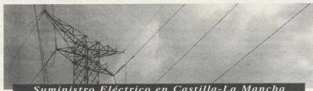
Suministro Eléctrico en Castilla-La Mancha
