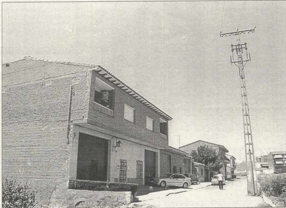
Los vecinos denuncian la existencia de una torreta de alta tensión en el barrio
