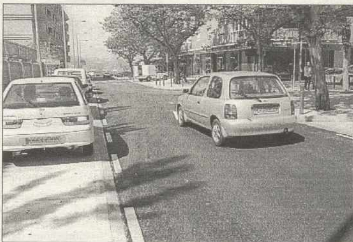
Se ha repuesto el pavimento y ensanchado el acerado
