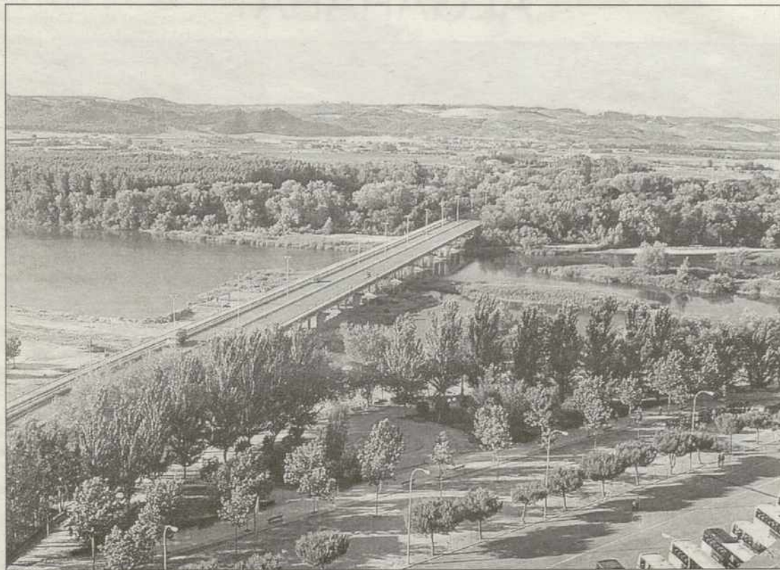
La margen izquierda del Tajo recuperará para uso ciudadano 25 hectáreas de ribera
