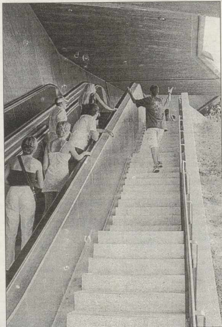
Las Escaleras Mecánicas del Paseo de Recaredo
