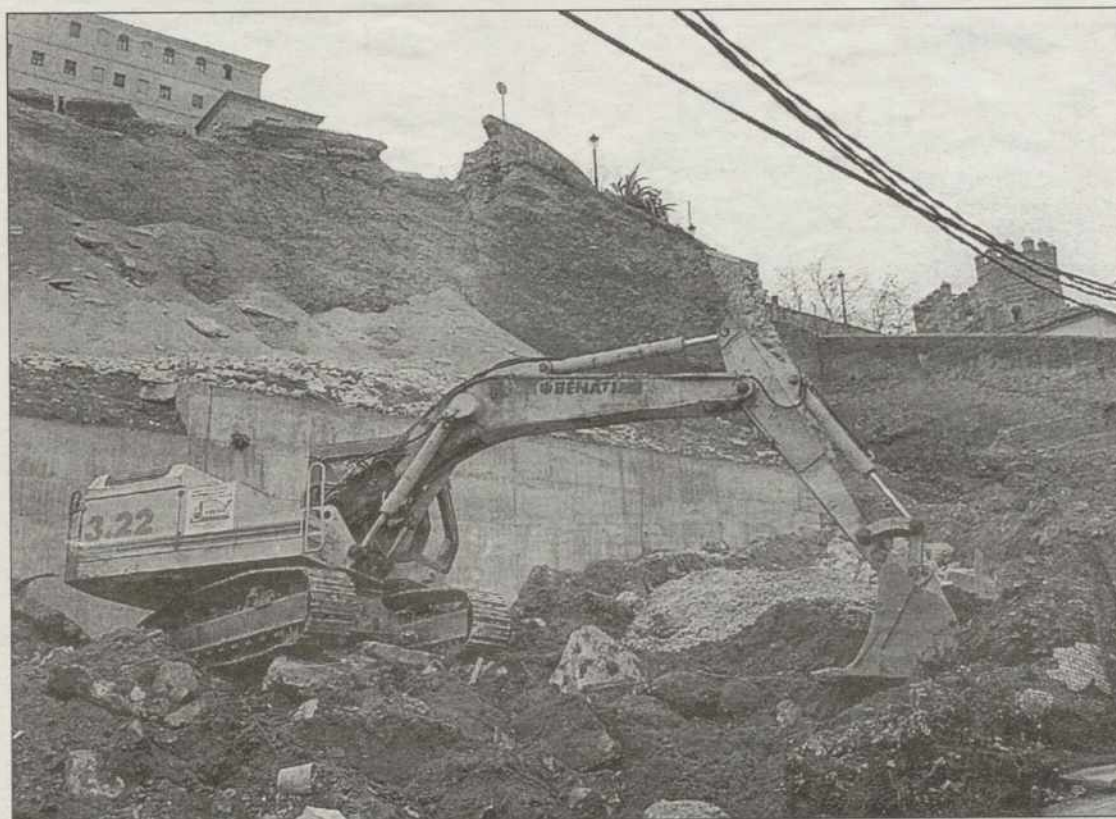
El Ayuntamiento ha comenzado ya el trabajo de reposición del muro de la calle Azacanes
