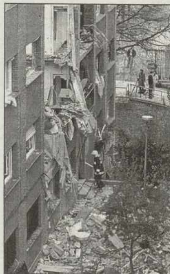
La vivienda derruida
