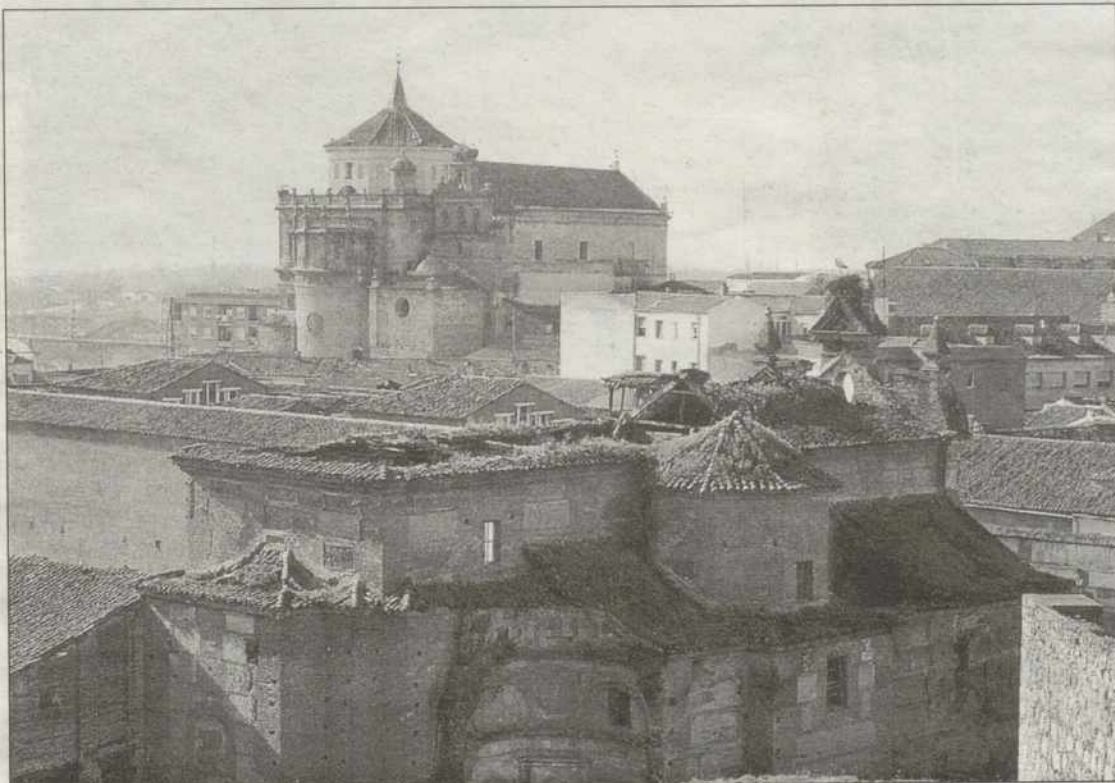
El Ayuntamiento acometerá la limpieza de los restos que aún queda de la cubierta
