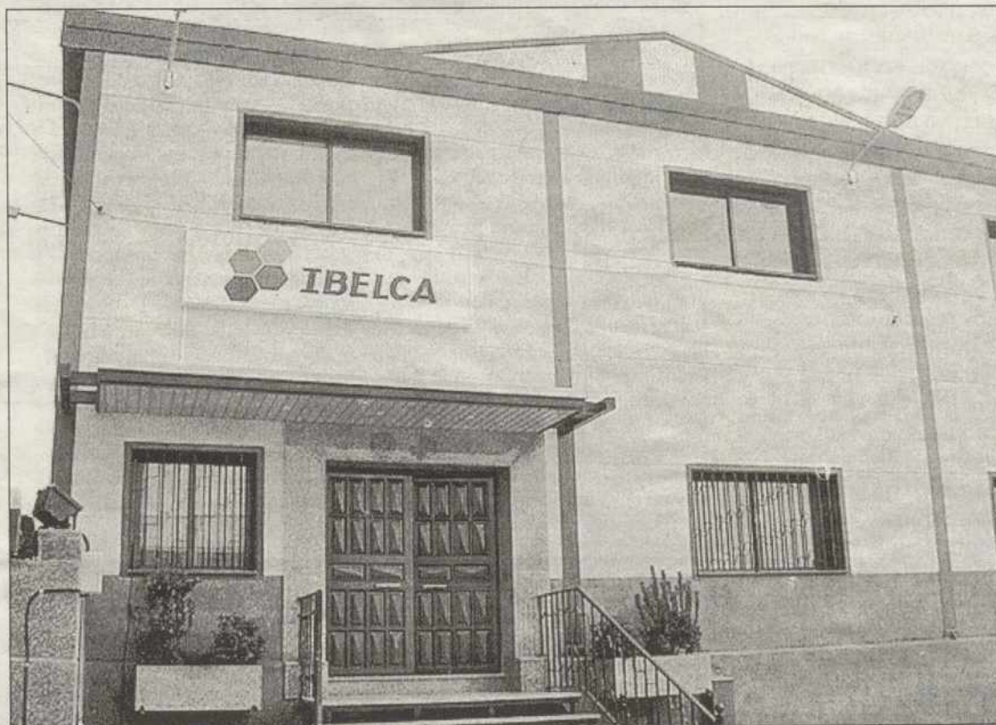
IBELCA desarrolla una técnica de camuflaje que integra a las casetas que alojan los equipos de telecomunicaciones
