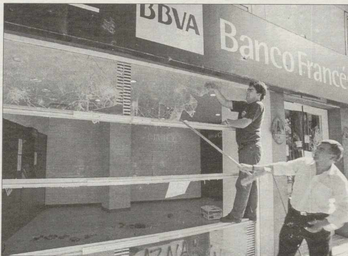
Empleados de una sucursal del BBVA retiran los cristales dañados de la oficina
