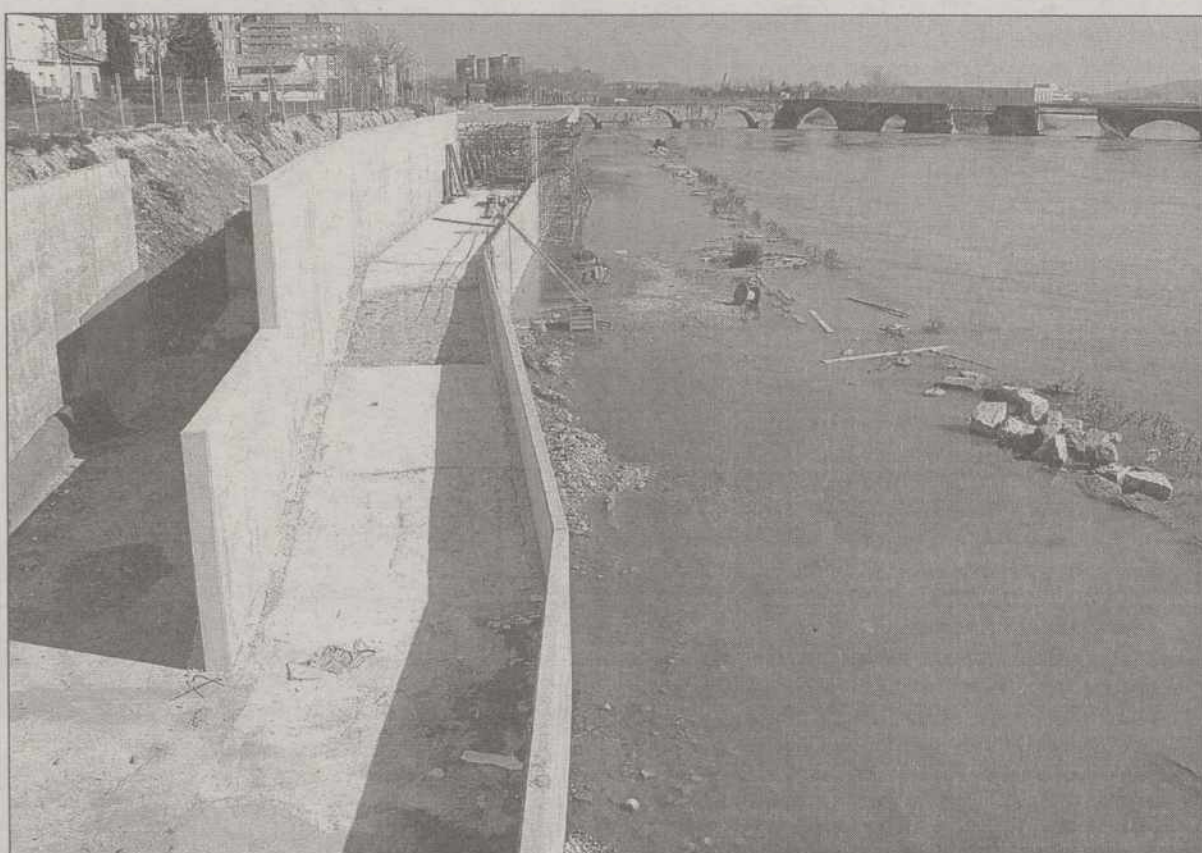
El cambio operado en la margen derecha del Tajo es más que notable; en la imagen, las obras.
