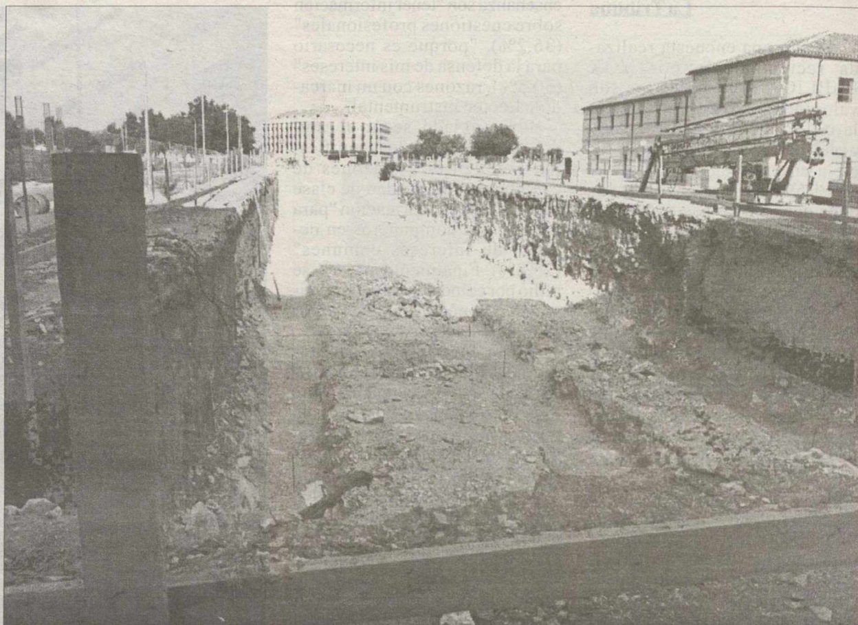
Las obras podrían finalizar dentro de seis meses.
