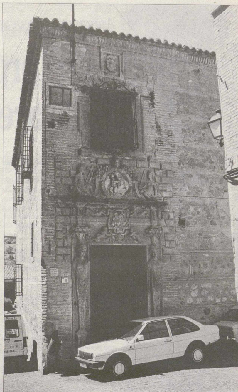
El Colegio de Infantes necesita ser restaurado.
