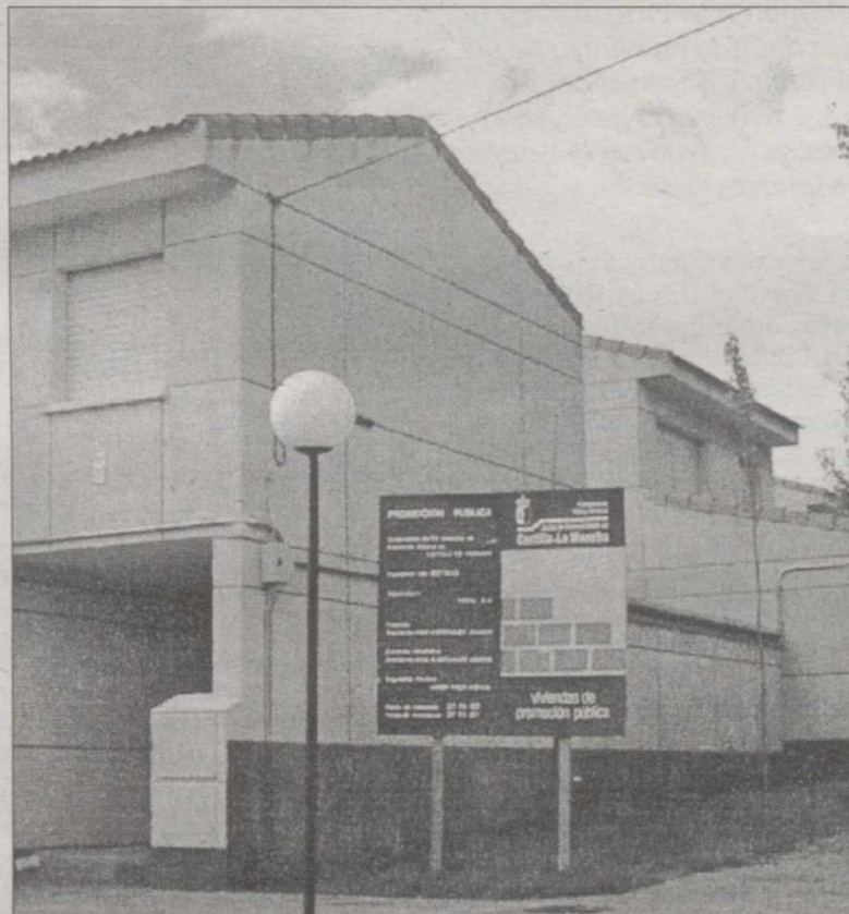
Burguillos también quiere viviendas de Protección Oficial.
