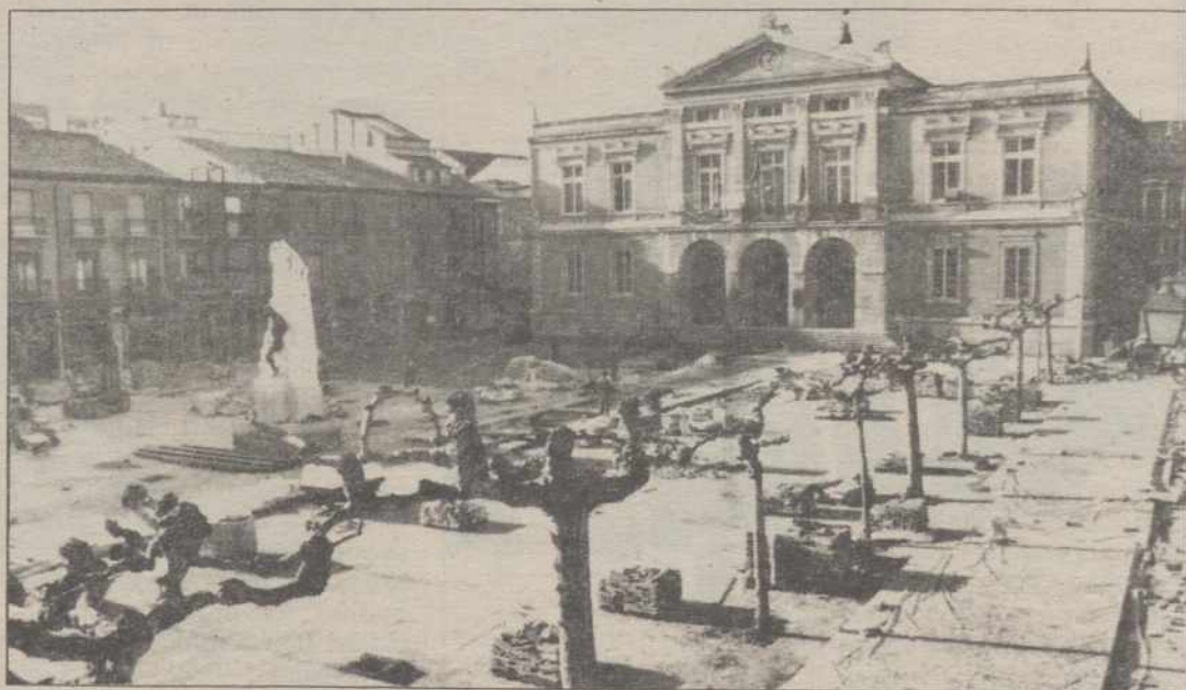
Se ha instalado material plástico entre el hormigón y el pavimento
