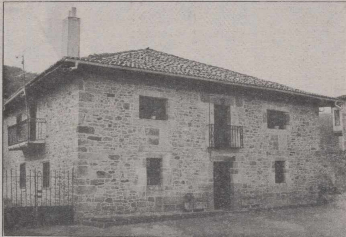
San Salvador de Cantamuda: Casa solariega, construida en 1841.-(Foto Piedad Isla).
