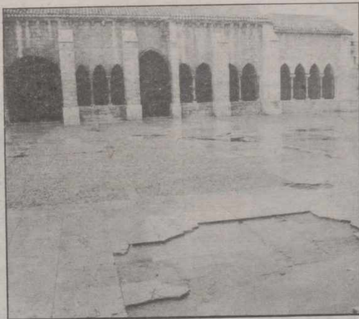
La Plaza de San Francisco tendrá un nuevo pavimento
