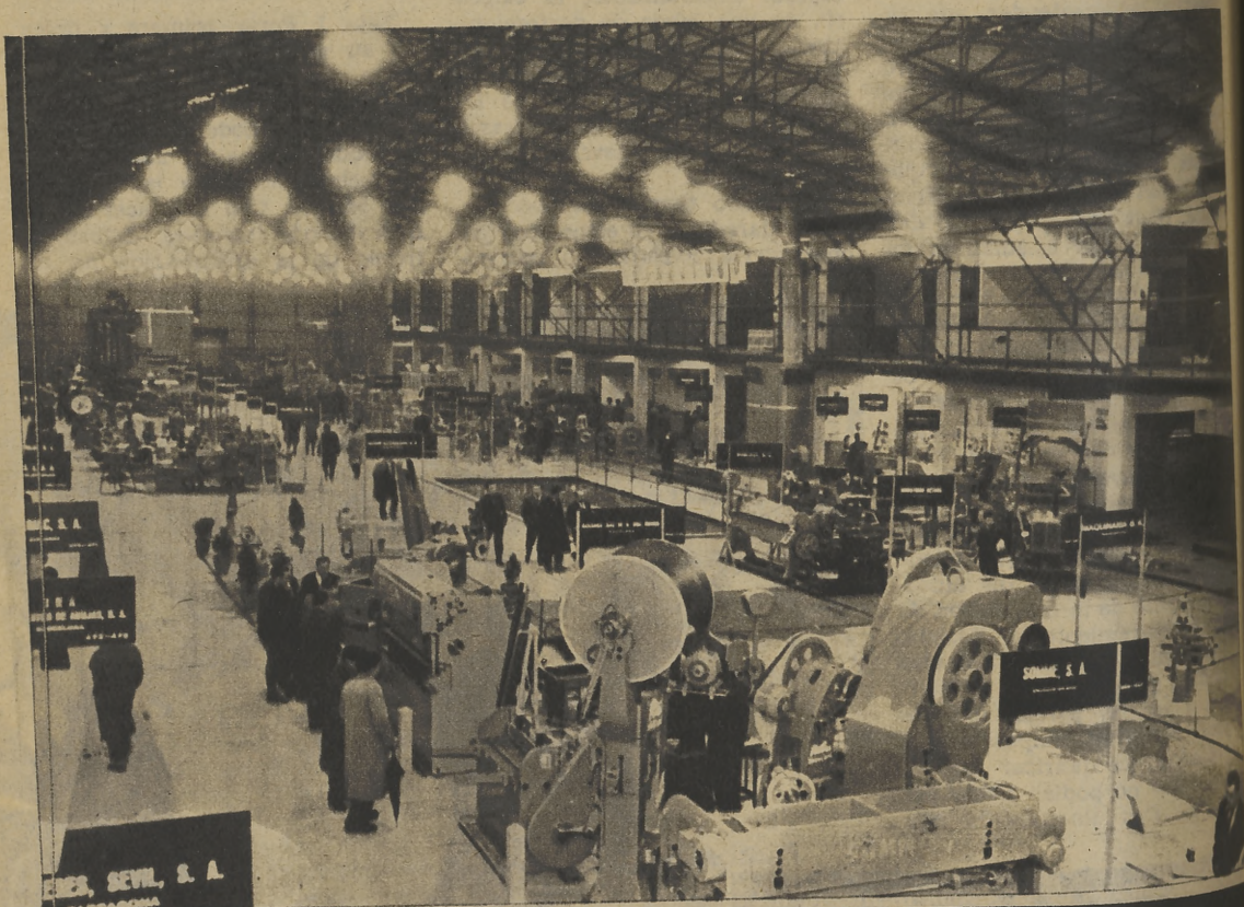
Uno de los varios pabellones desmontables, construidos a base de mecanotubo y uradita
