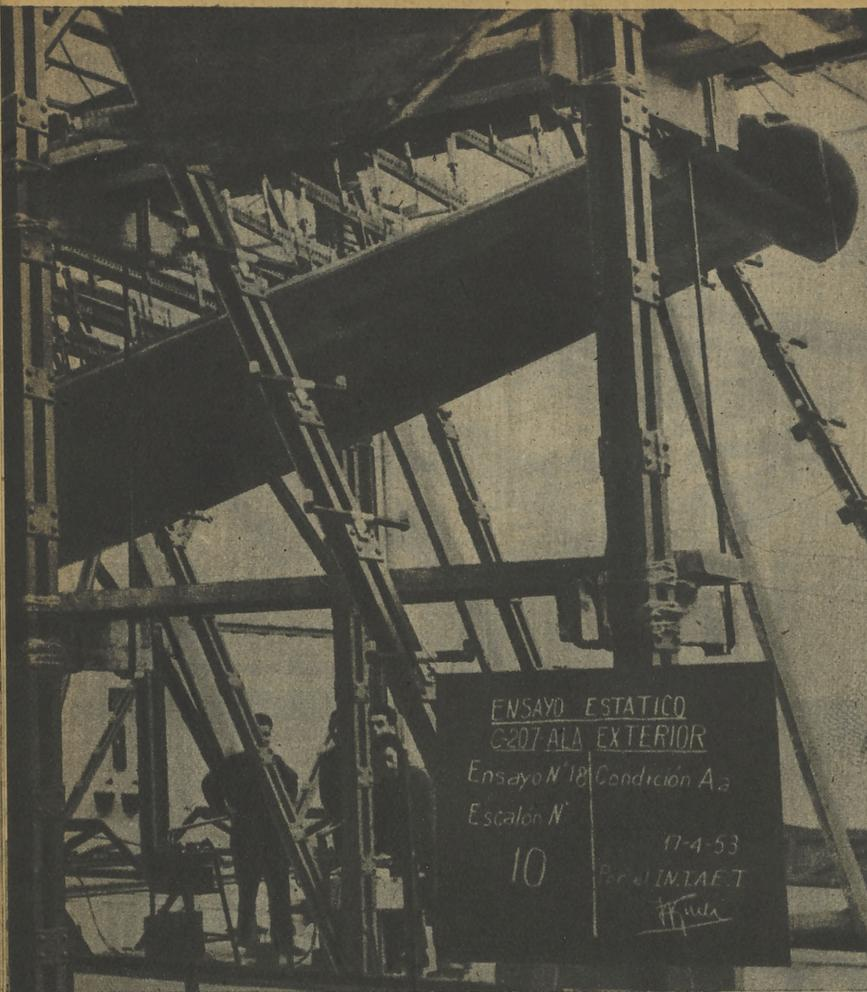
Todos los elementos del nuevo avión español son meticulosamente comprobados. En la fotografía, el ensayo estático de un ala, realizado en los talleres de la C. A. S. A.
