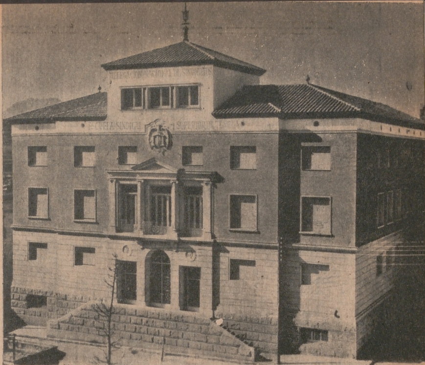
Fachada principal de la Escuela Sindical Superior de Tenería
