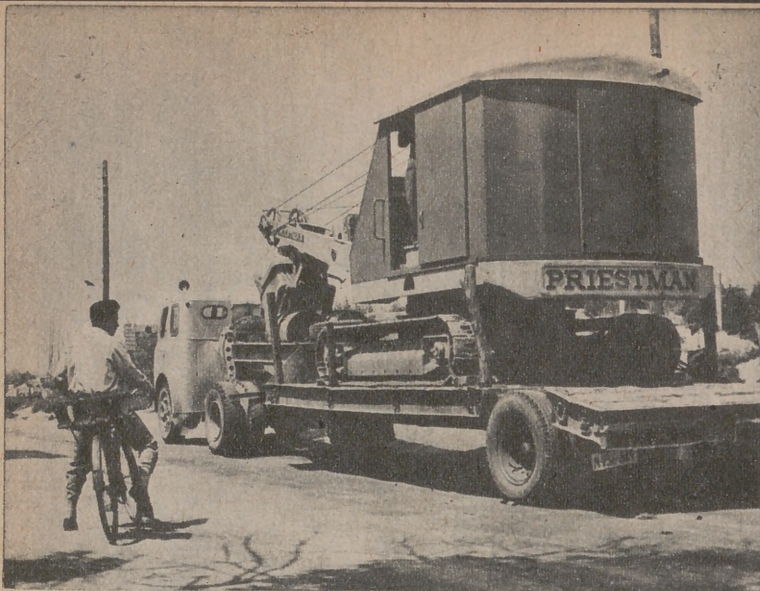
Es frecuente encontrar en las carreteras transportes de este tipo, máquinas que se utilizan en la transformación del paisaje español
