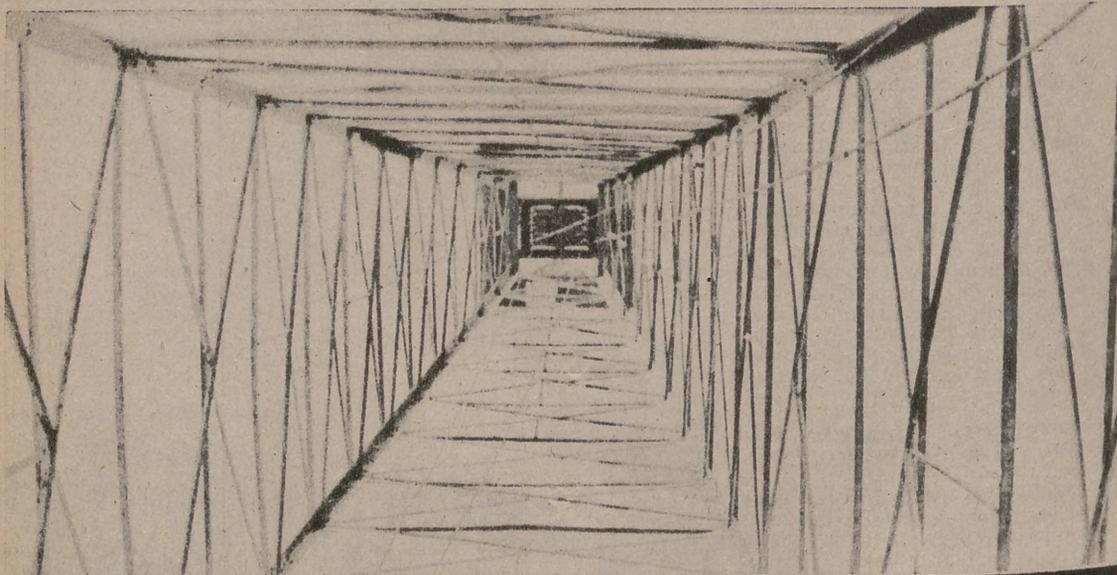
Estructura de una de las torres de perforación empleadas para buscar el agua en los campos de Dalias y de Nijar
