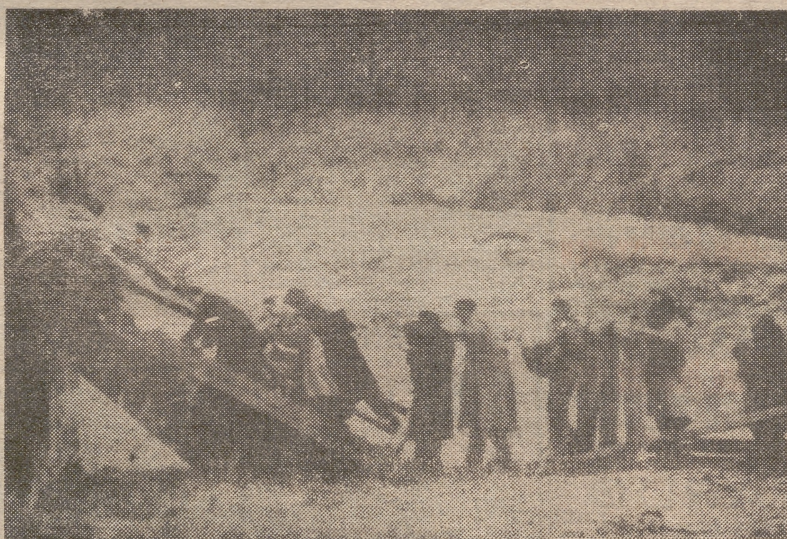
BURGENLANDIA (Austria).—Un grupo de refugiados húngaros atraviesa el puente hundido sobre un canal, cerca de la frontera austrohúngara. Es uno de los muchos puentes hundidos por los soviéticos para evitar el éxodo de los patriotas. (Foto Cifra Gráfica.)
