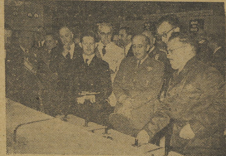
Una instantánea de la visita del Jefe del Estado a la central hidroeléctrica de Cofrentes
