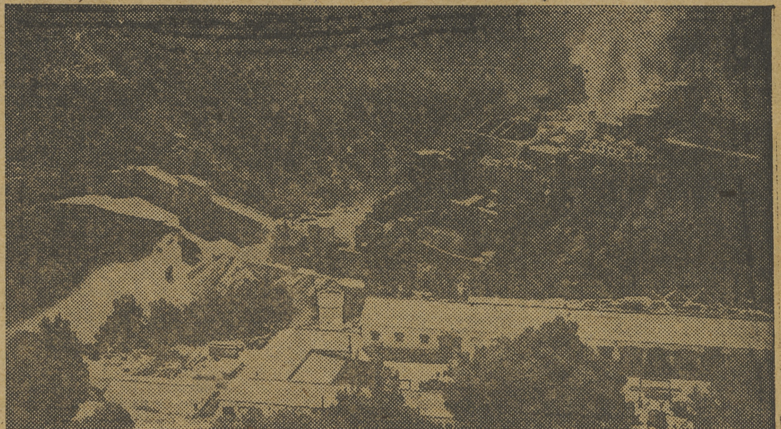
Vista de la presa y fábrica de cemento. (Foto Pérez Solanos)
