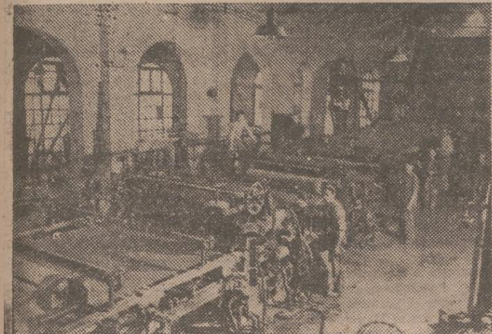
Transformada la pasta en papel, éste sufre la acción de prensas exprimidoras y de cilindros secadores a vapor
