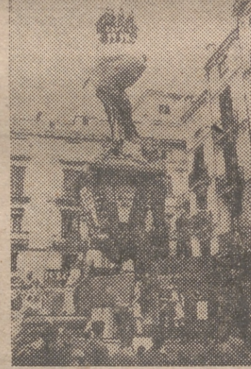
Falla de la plaza de la Merced Primera sección
