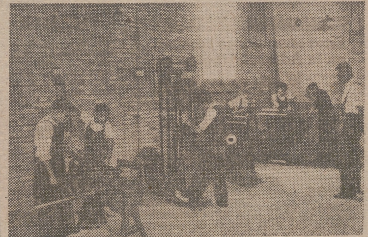
Un aspecto de la sala de maquinarias
