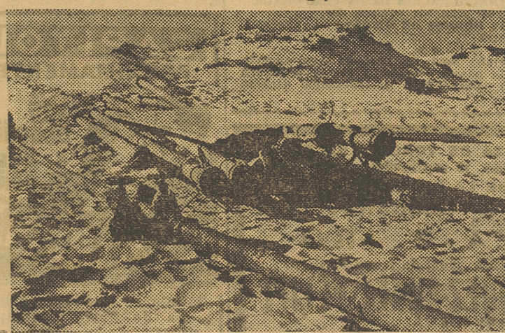
Tuberías preparadas para llevar a los depósitos el agua del subsuelo. — (Foto Cifra)
